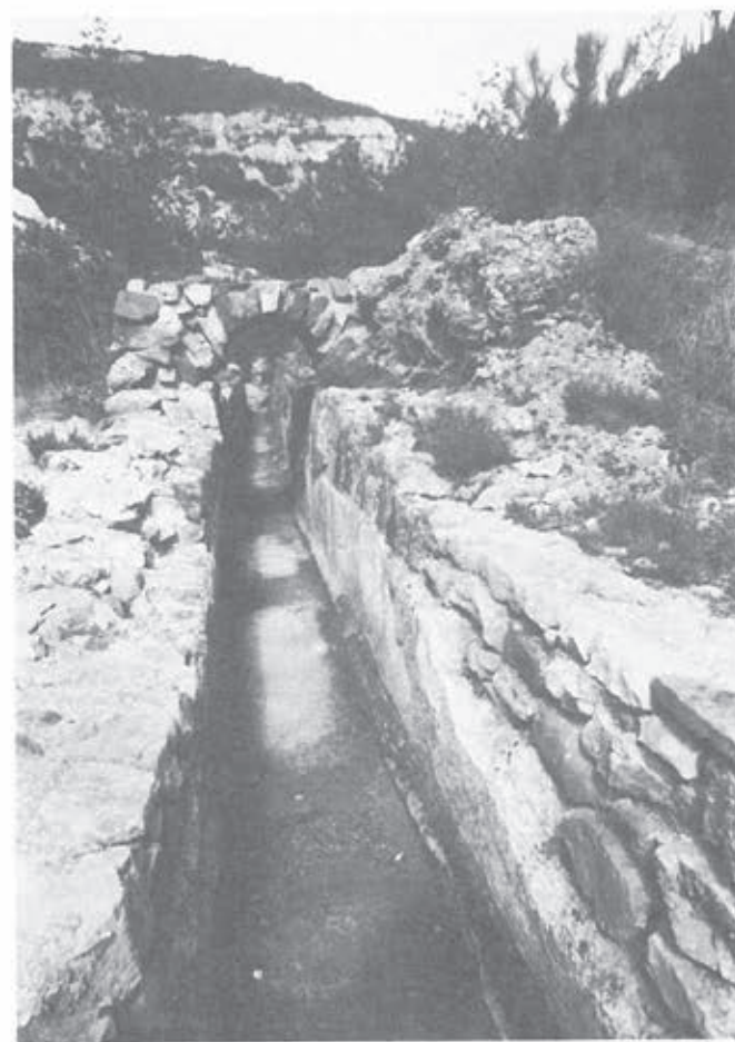
Sl. 3. Pogled na restavrirani del rimskega vodovoda v dolini Glinščice nad Gorenjim Koncem Fig. 3. Il canale dell'acquedotto romano nel tratto restaurato nella Val Rosandra
